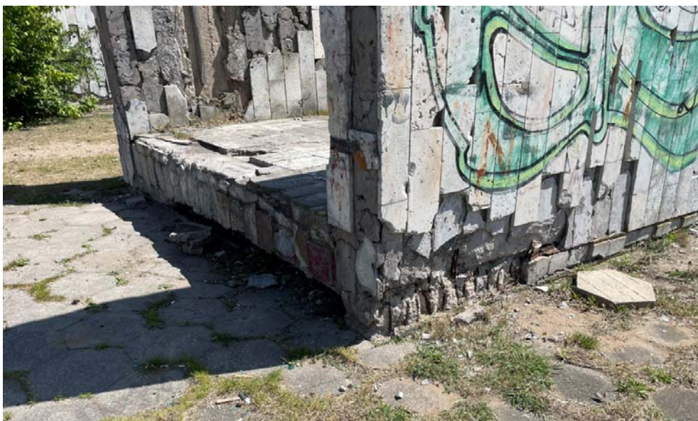
Pav. 5 Atraminių sienučių armatūros apsauginio betono sluoksnio, apdailos pažaidos
