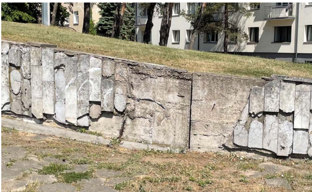
Pav. 4 Atraminių sienučių deformacinė-temperatūrinė siūlė, apdailos pažaidos
